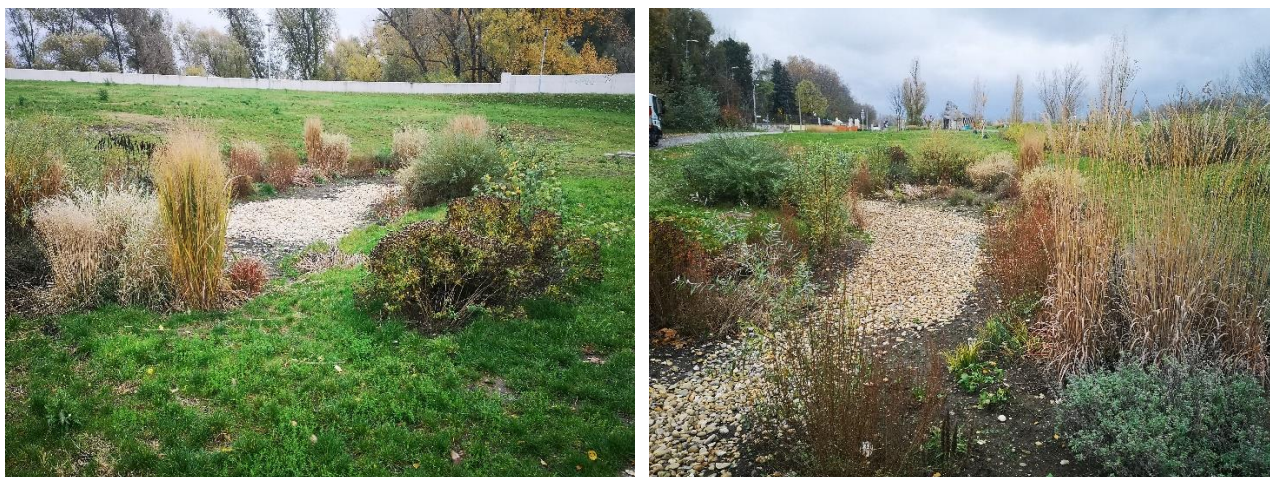
14. ábra Csapadékvíz elszivárogtató medencék Pünkösdfürdőnél
