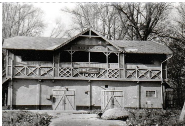
4. ábra Bibic csónakház a felújítása előtt
