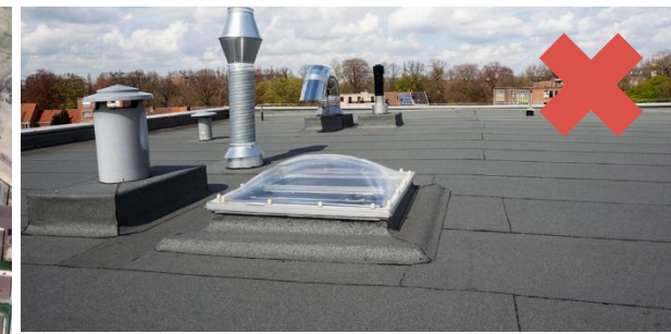
Sötét tetőfelület ( https://www.hustadcompany.com/pros-cons-flat-roofs/ )
