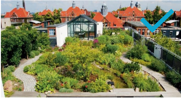
Intenzív zöldtető a DRK Wiegmann Klinika tetején Berlinben ( https://www.urbangreenbluegrids.com/measures/green-roofs/intensive-green-roofs/ )
