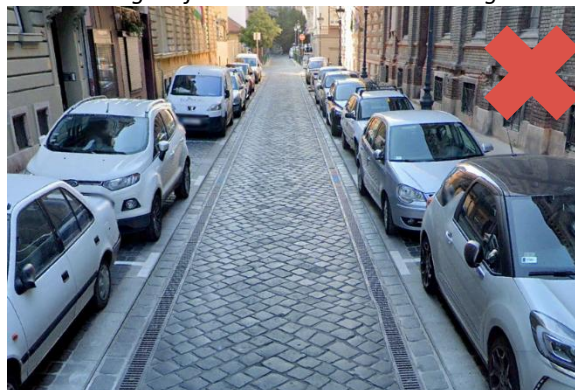
Esztétikus, de lakó környezetben zaj szempontjából kedvezőtlen nagykockakő burkolatú kiszolgálóút
