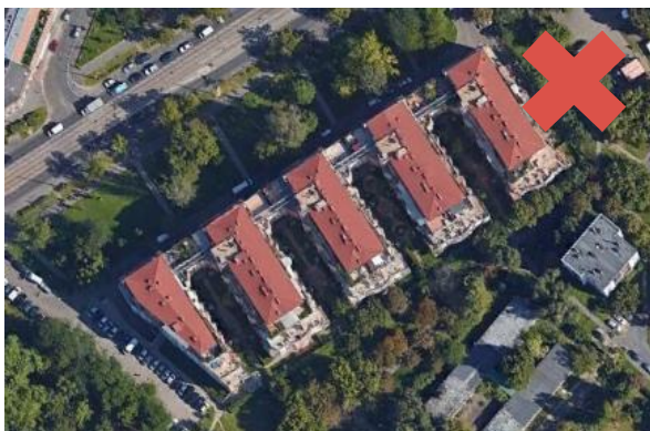
Lakóépület kedvezőtlen légtérarányú, három oldalról zárt udvarterei
