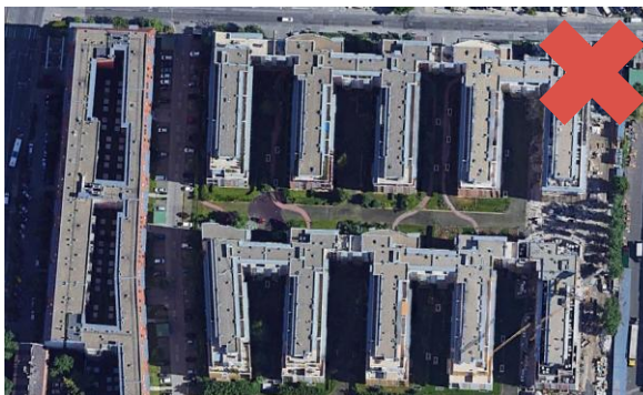
Kondorosi lakópark, Bp. XI. kerület – lakóházak zöldfelületek alacsony aránya (zf. arány: ~ 23%, teljes értékű zf. arány: ~ 3%) (Google Earth)
