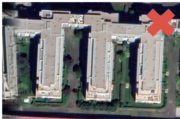
Lakóépület kedvezőtlen légtérarányú, három oldalról zárt udvarterei
