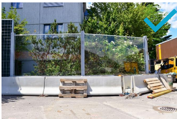
Építési terület elhatárolása hanggátló kerítéssel ( https://www.acryline.ch/EN/noise-barrier/ )
