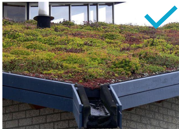
„Ultrakönnnyű” extenzív zöldtető (50-70 kg/m 2 ) ( https://zoldtetok.hu/ultrakonnnyu-extenziv-zoldteto/ )
