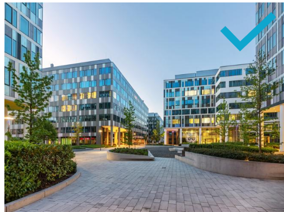
XIII. kerület, Váci Greens. A viszonylag magas szintterületi mutató ellenére az épületek közötti terek és az épületek földszinti átmeneti terei és átriumai a környező közterületekkel funkcionális és vizuális kapcsolatban vannak, átjárhatóak. ( http://www.vaciqreens.hu/ )
