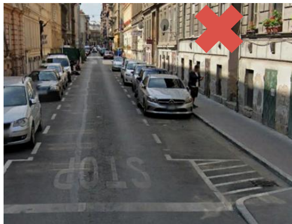
Városképi szempontból előnytelen kialakítású, kizárólag aszfaltburkolatokból álló kiszolgálóút
