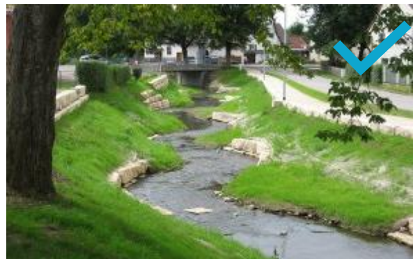
Meanderező kisvízi meder, kő és gyepes meder kombinációja, gyepes partrézsű (Stanzel-patak, Németország) ( https://gruellmeier-lfs.de/projekte/gestaltung-stanzel-innerorts/ )
