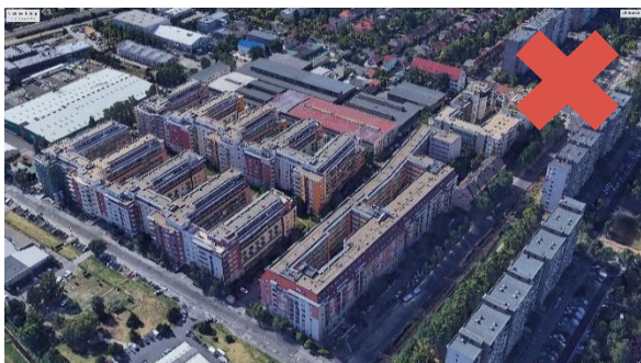
XI. kerület, Kondorosi lakópark. A szomszédos, alacsonyabb lakóterülethez képest környezetében túlépített hatást kelt. Nem rendelkezik megfelelő nagyságú és arányú zöldfelületekkel, átjárhatóság és tagoltság nem megoldott. (Forrás: Google Earth)
